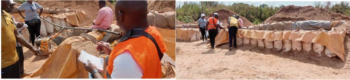
Figure 5. Figure 6. Bassin de décantation au cyanure avec des tuyaux remplis des copeaux de zin
